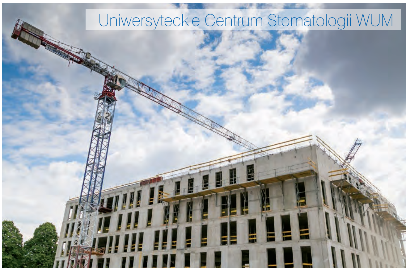
Gmach UCS w dniu wmurowania Aktu Erekcyjnego
