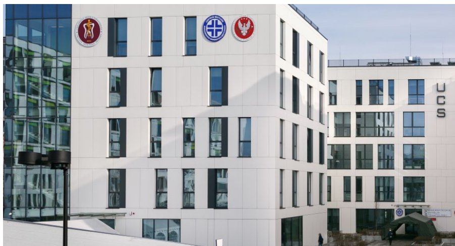
Budynek Uniwersyteckiego Centrum Stomatologii WUM
